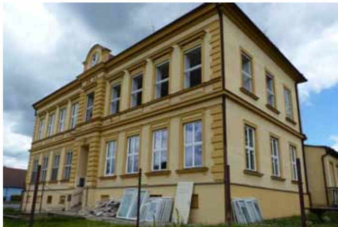
Rekonstrukce školní budovy
