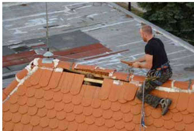
Oprava střechy kostela panem Martinem Novotným
