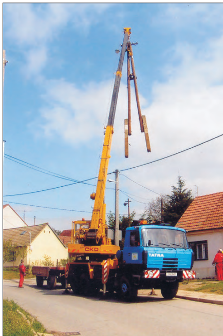
V Dalešicích probíhá rozsáhlá rekonstrukce rozvodů elektřiny.
